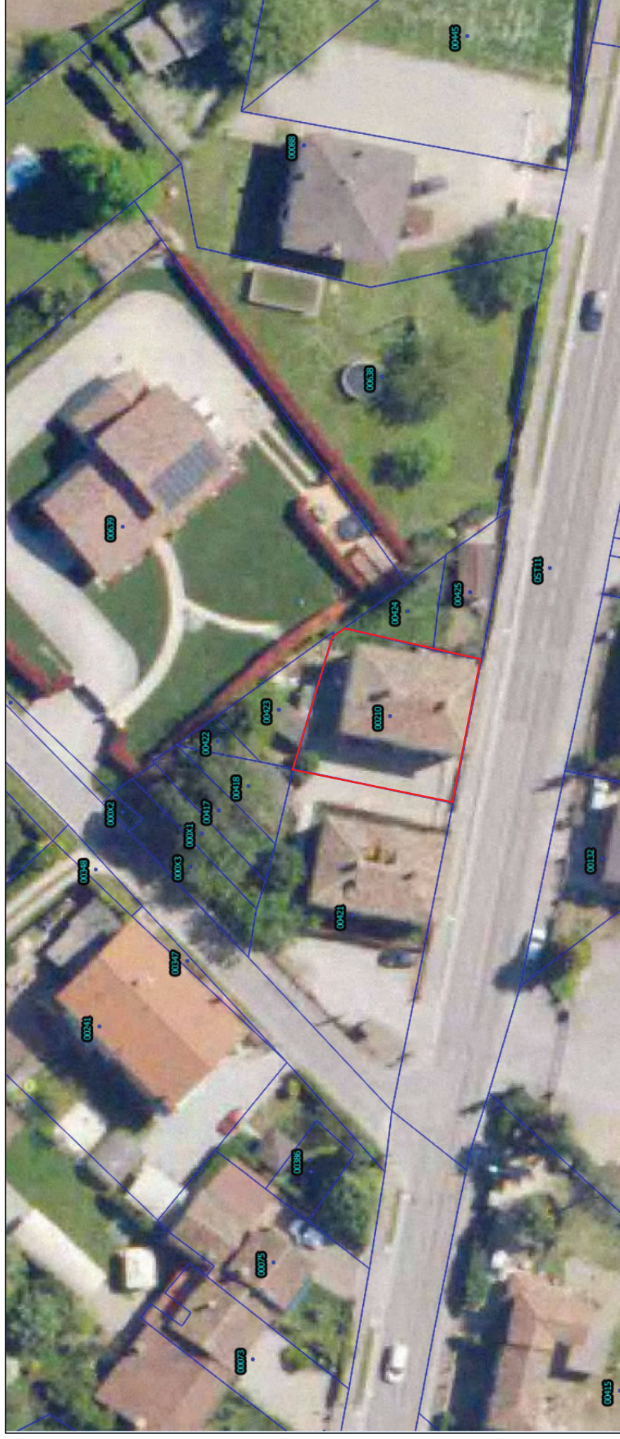
Foto n. 3 – Foto aerea con particolare del fabbricato residenziale.
