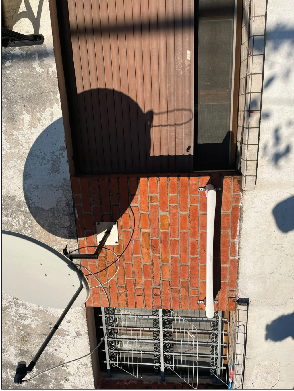
Foto n. 6 – Foto del fabbricato lato est.
