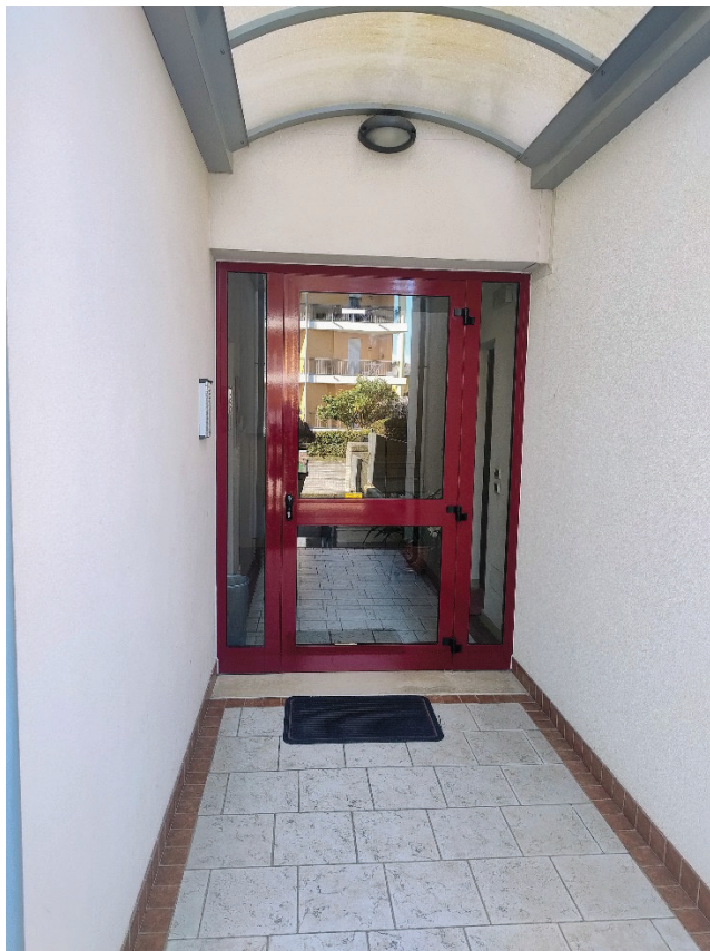
PORTONCINO INGRESSO CONDOMINIALE
