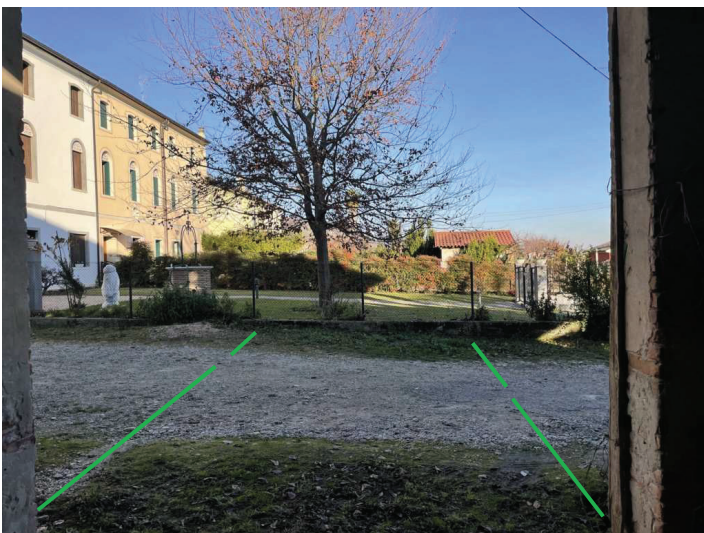
foto n. 17 – individuazione porzione area scoperta fronte est
