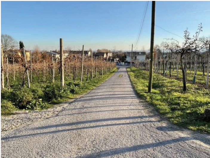
foto n. 3 – ingresso al lotto – vista da nord verso S.P. n. 32
