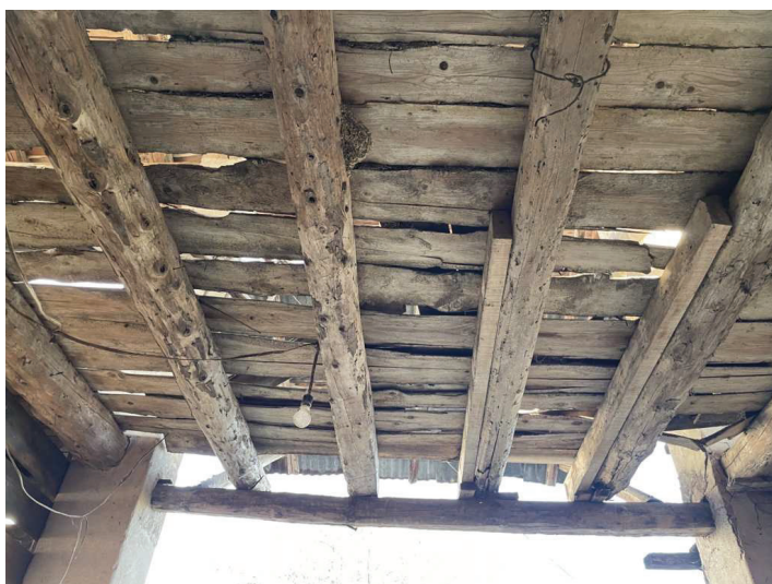
foto n. 9 – solaio locale di accesso
