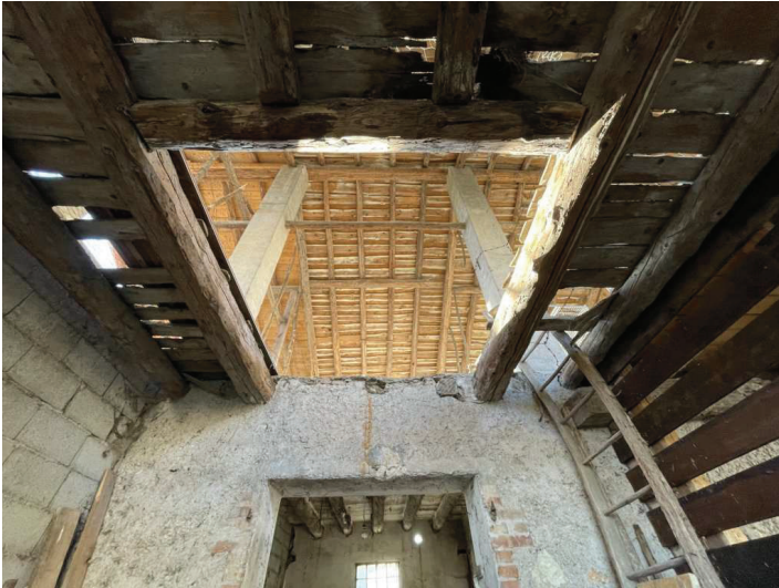
foto n. 13 – vista P1 e copertura dal locale di accesso al PT
