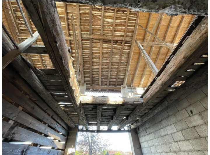
foto n. 14 – vista P1 e copertura dal locale di accesso al PT
