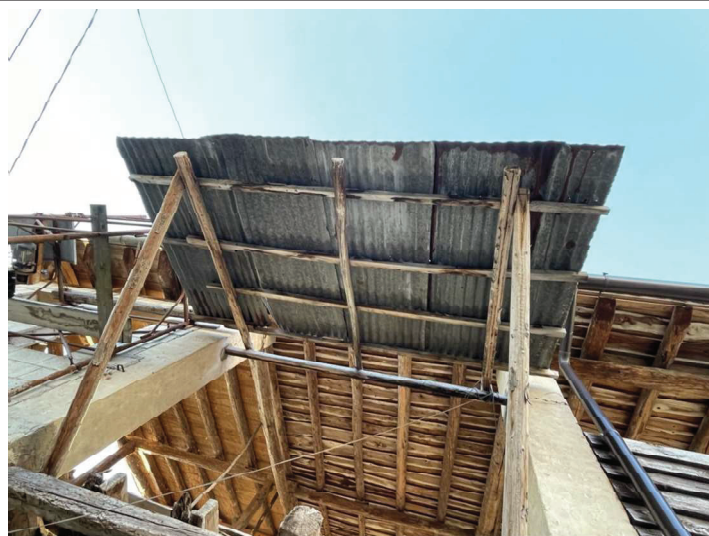
foto n. 12 – tettoia su prospetto est
