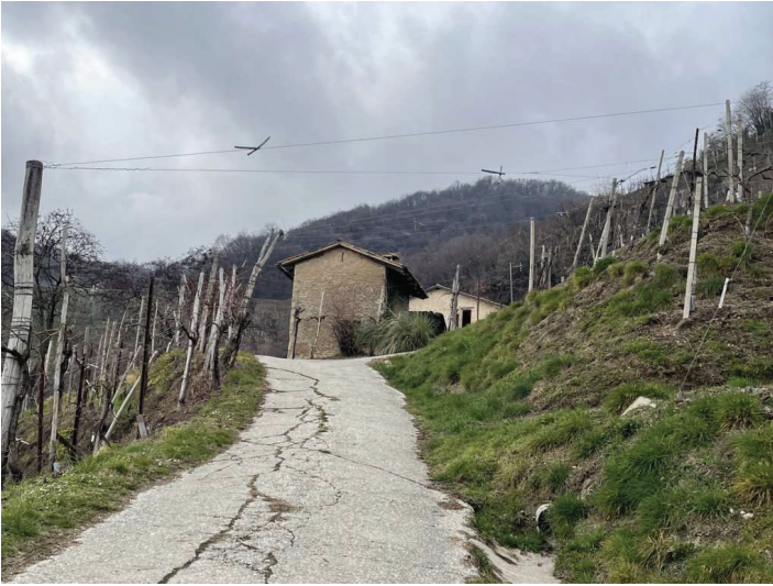
foto n. 1 – manufatto e bivio al km 1,4 su via S. Giorgio in corrispondenza del quale si gira a destra ( n. 1)
