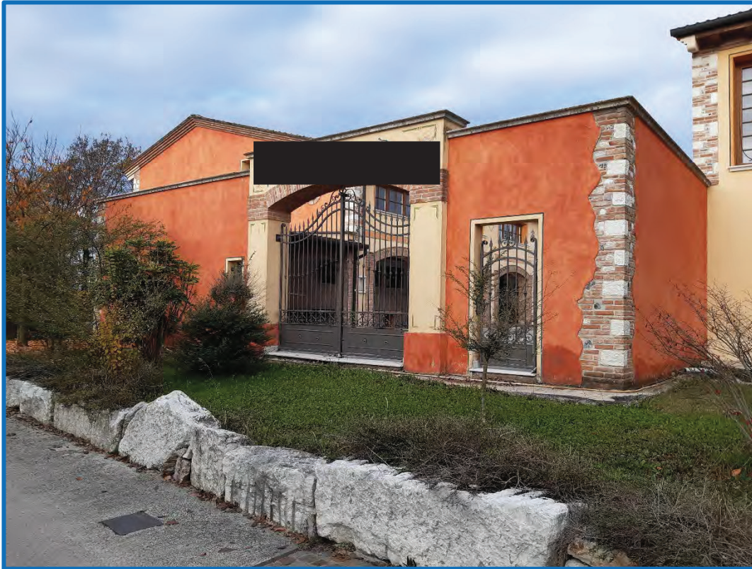
n° 1 – Particella Mn 432 – accesso da via San Pietro
